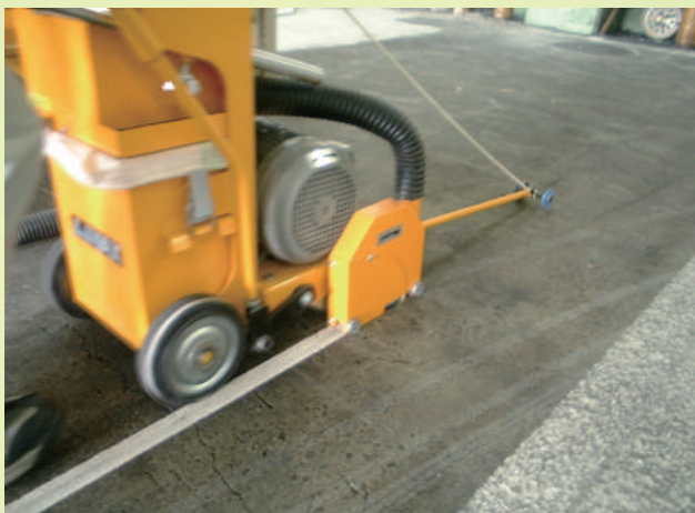
2.5mm幅カッターを使用しての誘発目地切り▼
